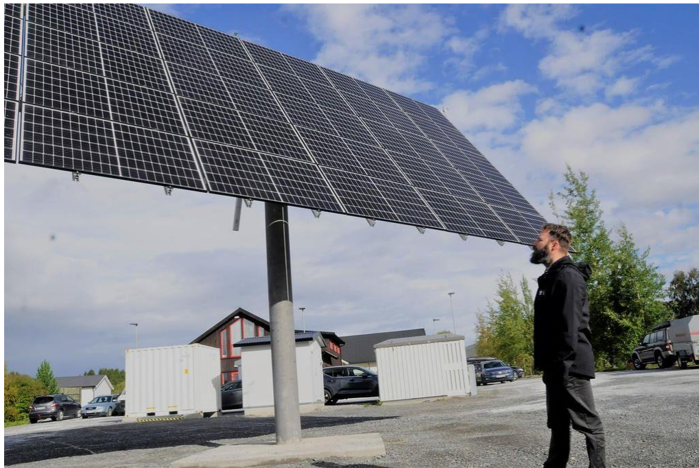
Figur 6 - ISE Zen AS på Fauske sin tracker med solcellemoduler som følger solen. Foto: Maria Edvardsen, Saltenposten
